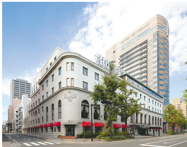
横浜を代表する歴史的建造物ホテルニューグランド。同社が施工し、その後も保存・改修工事を手掛ける
