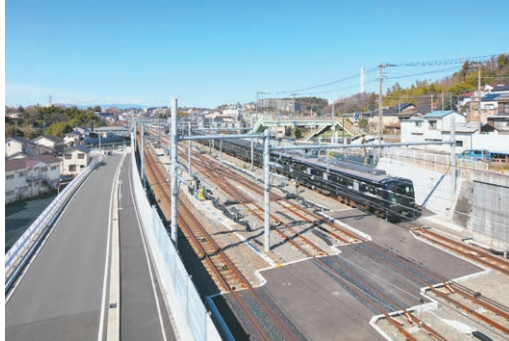
相鉄東急直通線西谷駅留置線新設工事
