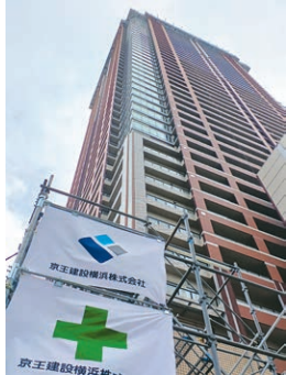
大規模修繕工事
