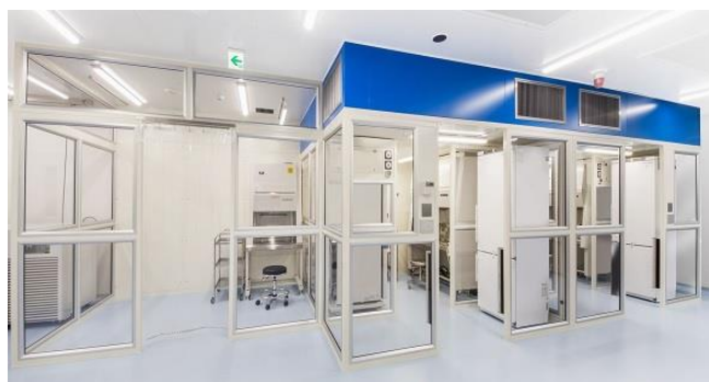
写真 エアバリアブースを用いた 大部屋型 CPF
